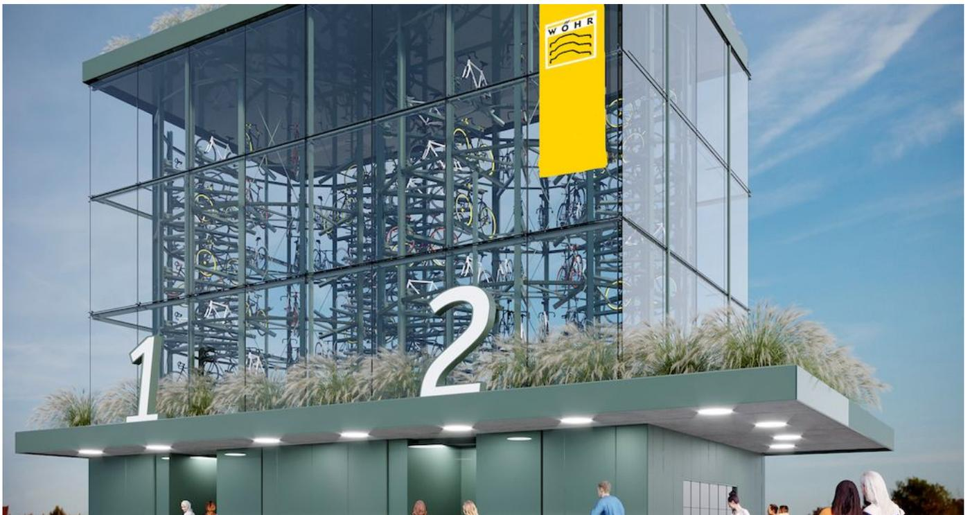
Zwei WÖHR Bikesafe Türme mit zwei Übergabepunkten, beleuchtete und begrünten Dachvorbau und Schließfächern mit E-Bike-Ladestellen. Rechteckiger Vorhang mit verglaster Fassade.
