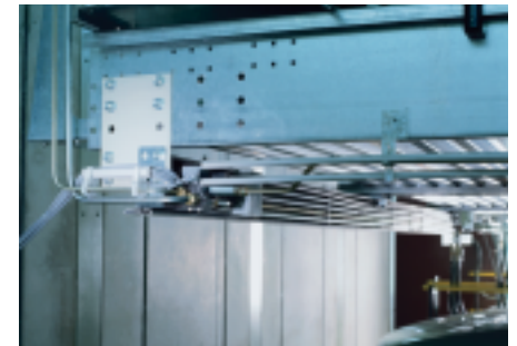
Neue Technik für die Verlegung der Hydraulik- und Elektrikleitungen. Der Baukörper bleibt frei für Lüftung u.a. und es gibt keine Geräuschübertragung durch Ölrückfluß.
