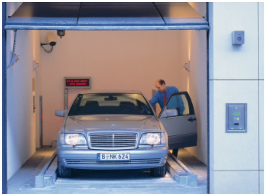
Erst wenn der Wagen im Einfahrtsraum zum Ausfahren bereitgestellt ist, öffnet sich das Tor, und der Fahrer kann sein Fahrzeug vorwärts in Fahrtrichtung ausfahren.
