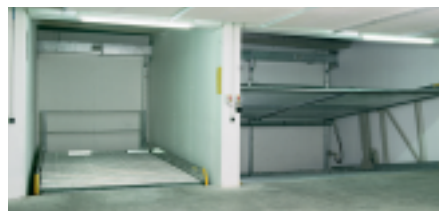
Rechts eine Doppelanlage angehoben, links eine Einzelanlage abgesenkt: die oberen Stellplätze sind waagrecht, die unteren geneigt.
