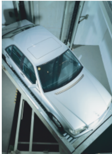
Eine in das System integrierte Drehscheibe bringt jedes Fahrzeug rechtzeitig in die richtige Position, damit es wieder vorwärts ausgefahren werden kann – ein Detail, das dem Benutzerkomfort dient.
