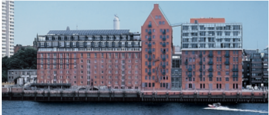
Das an der Elbe gelegene »Stadtlagerhaus« mit Speicher- und Silogebäude schafft nach Umbau und Aufstockung Platz für 28 Wohnungen, Bürolofts, ein Restaurant und 132 Auto-Stellplätze.
