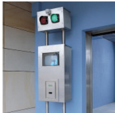
*Von links nach rechts: Zum Einfahren öffnet der Fahrer das jeweilige Anlagentor mit einer Fernbedienung, positioniert seinen Pkw auf einer ständig bereitstehenden Plattform und verläßt nach Beachtung der Bedienhinweise den Übergabebereich. Das Bedientableau befindet sich jeweils außerhalb des Übergabebereichs neben dem Tor. Nach dem Einschieben einer Magnetkarte als Bedienmedium und der Bestätigung einiger Fragen zur Sicherheit schließt sich das Anlagentor und der Einparkvorgang beginnt.*
