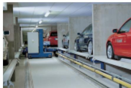
*Der schnelle neue Multiparker 740 zum Längsparken erreicht seine maximale Geschwindigkeit mit 125 m/min.*
