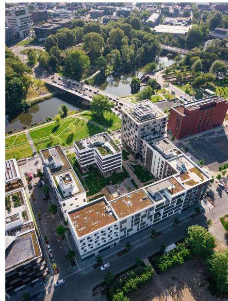
Bild 2: Unter dem Innenhof des beeindruckenden Bebauungsblocks J befindet sich die Tiefgarage mit WÖHR Combilift 542 und Parklift 405 Systemen für insgesamt 143 Stellplätze.
