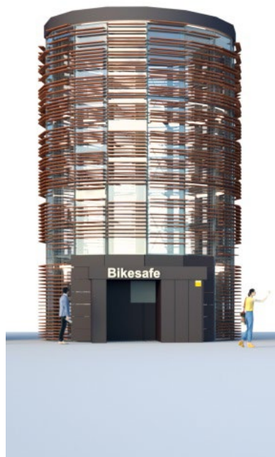
Fassadenbeispiel 2: bauseitige Gestaltungsmöglichkeit Glas und Corten-Stahl
