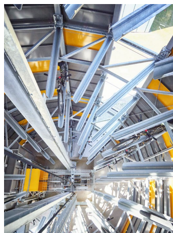
Bild 6: Im WÖHR Bikesafe lassen sich auf einer Grundfläche von nur ca. 38 m 2 bis zu 122 Fahrräder sicher einlagern. Die Radschienen, auf denen die Fahrräder eingelagert werden, sind besonders flächenoptimiert um den zentralen Vertikallift angeordnet.
