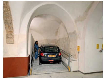
06 ihr Fahrzeug sichern, aussteigen und die Garage verlassen. Die Gewölbe der Gebäudestruktur ließen jeweils nur Parklift 313 mit 2 geneigten Plattformen zu.
