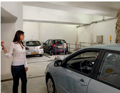
07 Bedingt durch die räumliche Enge werden die Stellplätze im hinteren Garagenbereich mit der Verschiebepalette 504 erschlossen. Die Fahrerin holt sie am Bedienelement automatisch vor ihren Pkw.
