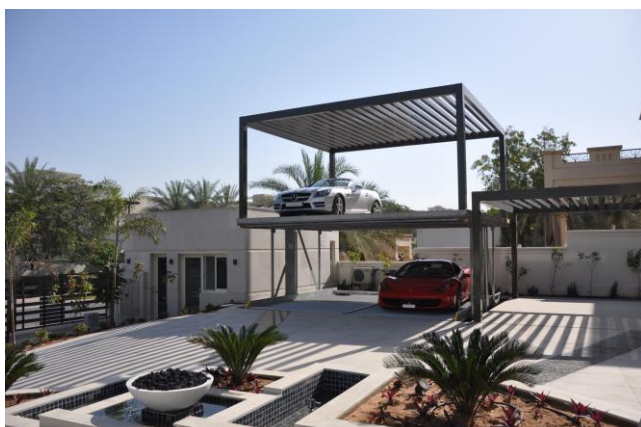
Bild 1 und 2: Der Parklift 461 D bietet zwei unterirdische Stellplätze. Durch eine geringe Modifikation der Deckelplattform und das Anbringen des Carports, entstehen zwei weitere Stellplätze auf der oberen Ebene.
