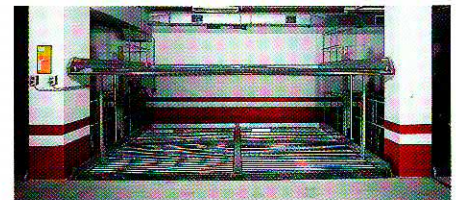
So sieht die Grundkonstruktion für 4 PKW ohne Fahrbleche aus. Die tragenden Seitengewangen sind aus feuerverzinktem Blech nach DIN 17162, NA 275 g/qm, die Traversen sind stückverzinkt nach DIN 50976.
