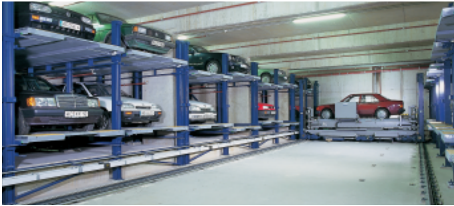
41 Stellplätze konnten auf zwei Ebenen links und rechts quer zur Fahrgasse des Regalbediengeräts angeordnet werden.
